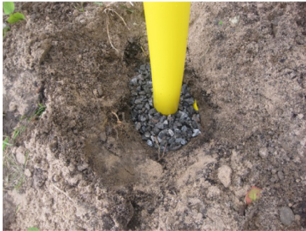
3. Återfyll med grusmaterial
